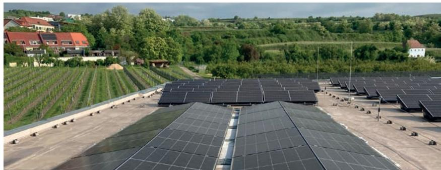
**Nachhaltiger Fortschritt an unserer Schule:** Auf der Landtechnikhalle der Landwirtschaftlichen Fachschule in Krems an der Donau wurde eine 10 kWp Photovoltaikanlage mit einem 20 kW Batteriespeicher installiert. Zusätzlich erfolgte der Austausch des Wechselrichters der bestehenden Anlage im Schulgebäude.
