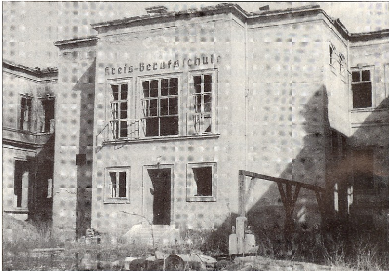
In der Dittrichstraße 12 stand die beschädigte Kreisberufsschule
